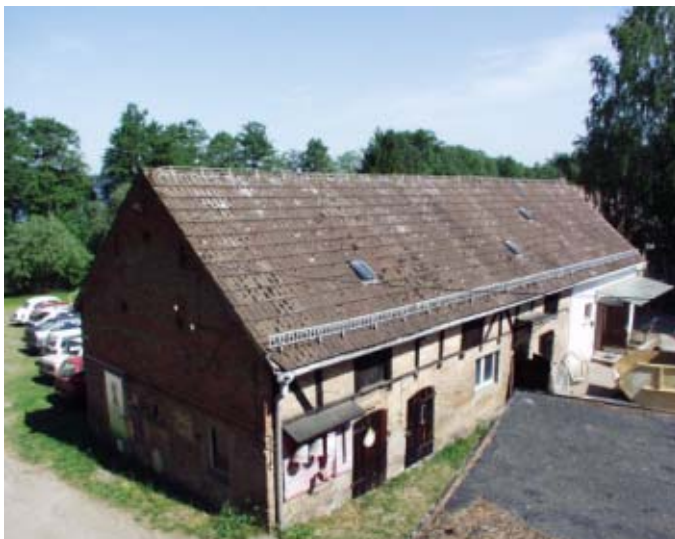
Das alte Institutsgebäude am Stechlinsee. Foto: IGB
